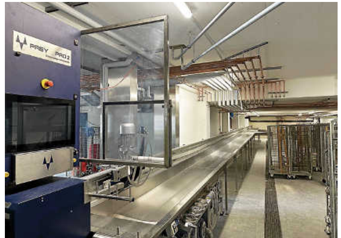
Die zentrale Schlauchwerkstatt für den ganzen Hohenlohekreis befindet sich im Pfaffenmühlweg Fotos: Stadt Öhringen
