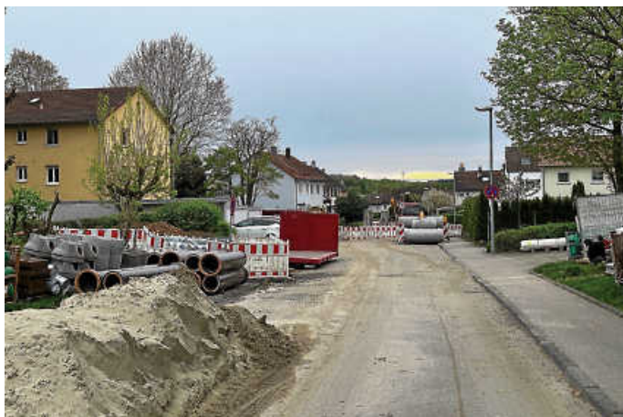
Der 2. Bauabschnitt in der Sudetenstraße hat pünktlich nach Ostern mit dem Kanalbau begonnen. Die Straße bleibt bis Ende August gesperrt Foto: Stadt Öhringen
