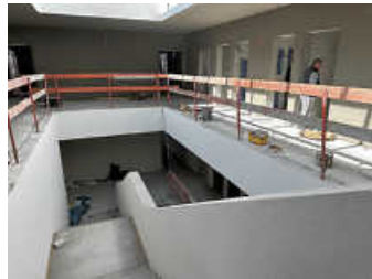
Putzarbeiten im Treppenhaus Foto: Stadt Öhringen
