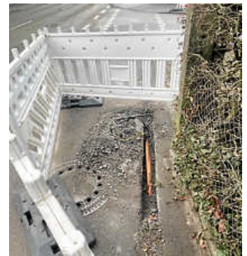
Die GigaNetz baut in Öhringen Glasfaserleitungen ein Foto: Stadt Öhringen
