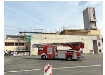
Fertiggepflastert ist der Hof der Feuerwache am Pfaffenmühlweg
